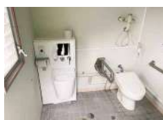
【多目的トイレ】
